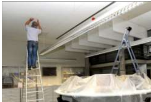
Abb.: Montage der CP 30 Elemente an der Decke
