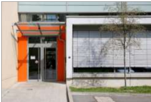
Abb.: Eingang Haus 42
